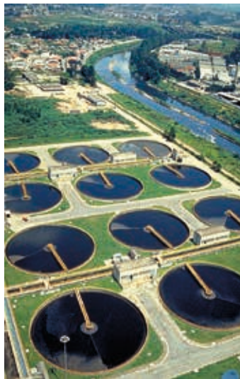
Estação de Tratamento de Esgoto - ETE Barueri/SP.
