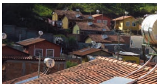
Coletores solares em conjunto habitacional de Minas Gerais Fonte: CEMIG. Foto de Sanderson Pereira.
